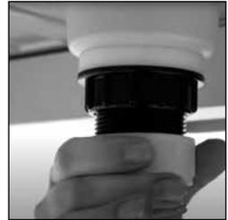
Abbildung 23 Auswechseln des Abflussschlauchs.
